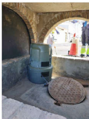
Instalación de tomamuestras
