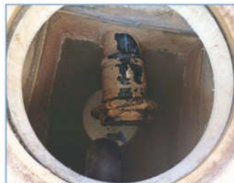
Estado interior de la arqueta
