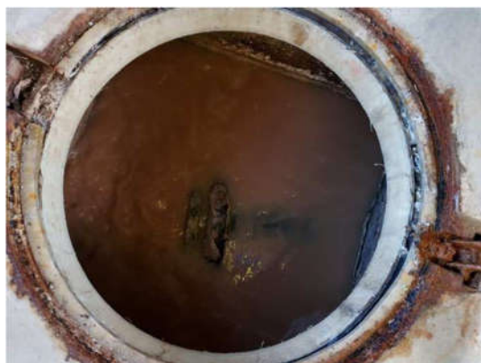
Vista de punto de vertido de Paviso Alimentación a la red pública de saneamiento el día 17/12/2025 a las 17:30 h.
